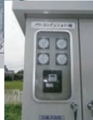
大分県竹田市の小水力発電プラント: 8mの落差を利用して25 kWの発電が可能 右は定周波数・定電圧とするための パワーコンディショナー制御盤
