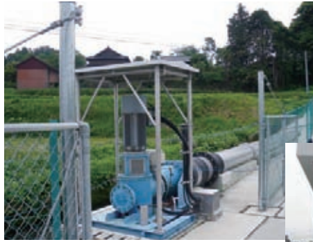
大分県竹田市の小水力発電プラント: 8mの落差を利用して25 kWの発電が可能 右は定周波数・定電圧とするための パワーコンディショナー制御盤
