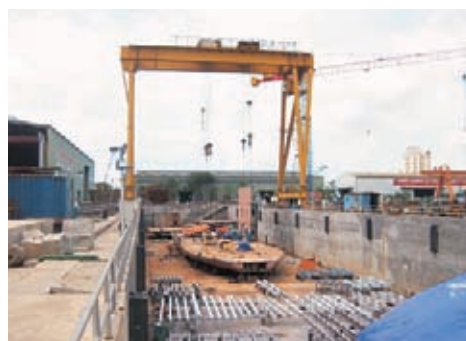
ドライドックでの小型船の組立作業風景
