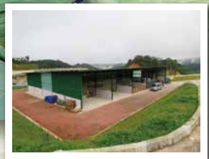
マレーシア国キャメロンハイランドのコンポストセンター
