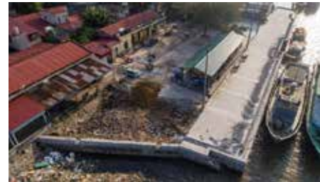
装置設置用地拡張工事完了
