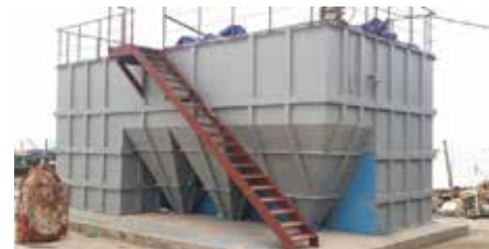
排水処理装置貯水槽据付完了
