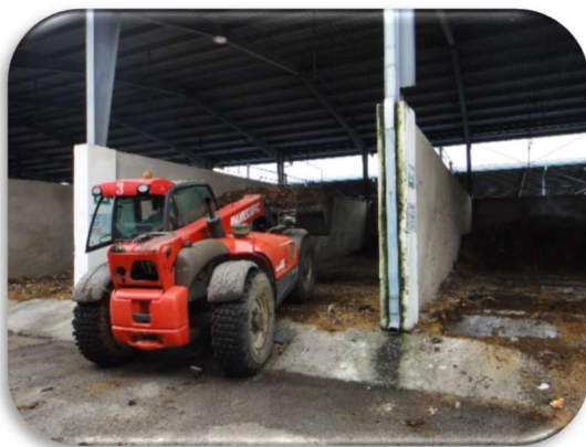
写真 5-150 確実に攪拌するために、別の槽に移動して攪拌
