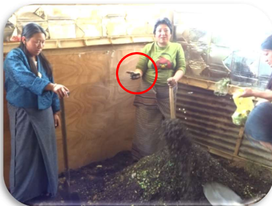
写真 5-68 攪拌途中で水分チェック
