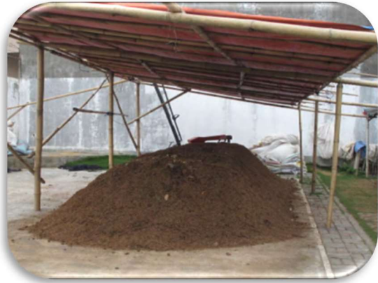
写真 5-80 竹の骨組み・屋根はテント張り
