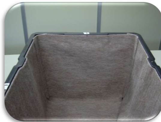
写真 5-43 隙間が無いようにふちは重ねて貼る
